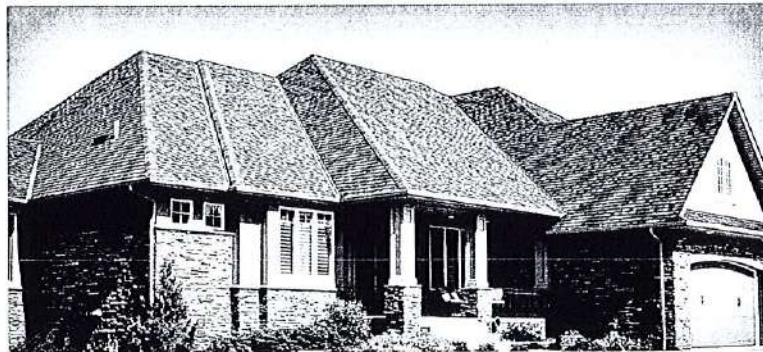
Foto 1.0 Bumbung dan dinding bangunan
